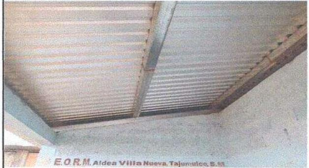
Foto 2: Estructura de soporte de madera por metal
